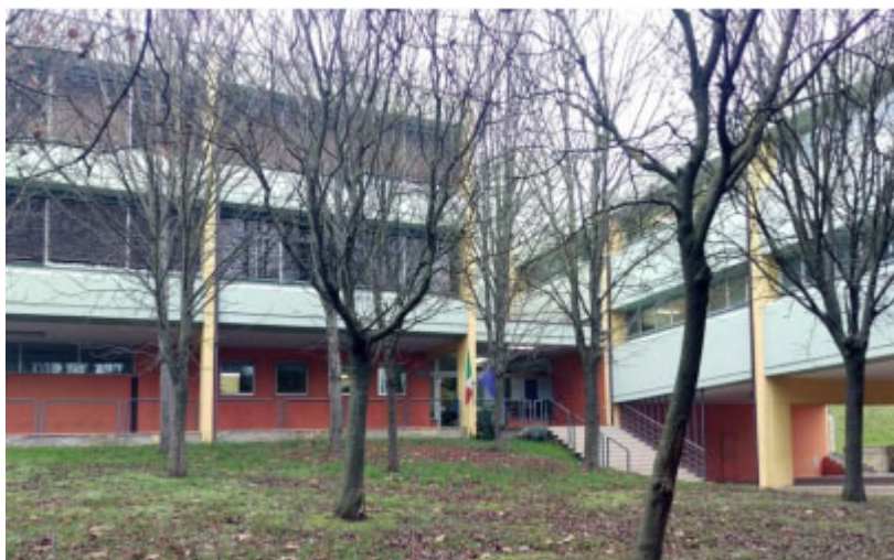
Scuola Secondaria Gabicce Mare
